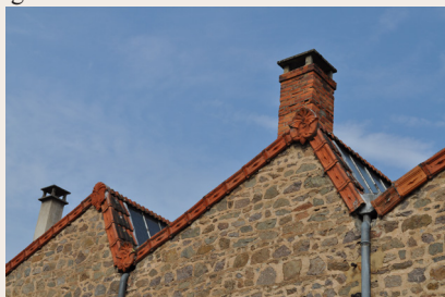
Toiture typique des ateliers
